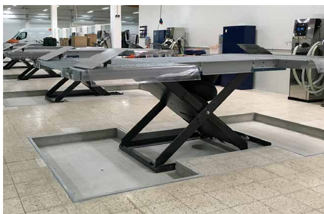
Im Beton mit Fundamentschutzrahmen ...
